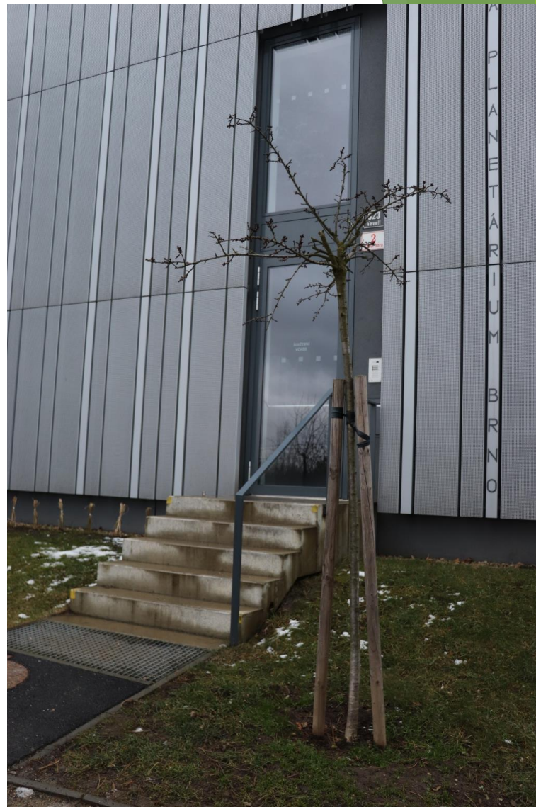
poškozené kotvení-povolené kůly
