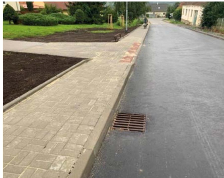
Výstavba chodníku v obci Vohančice
